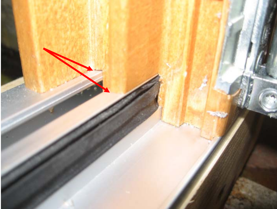
Bild 1 Eckausbildung Übergang Blendrahmen / Aluminium-Bodenschwelle, Kapillarfugen
